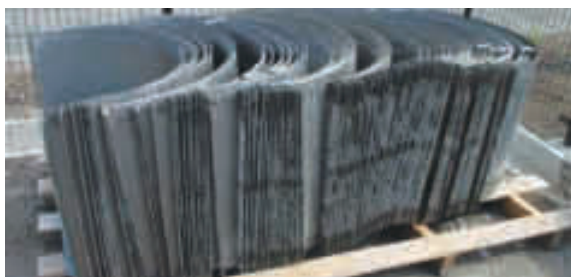
搬出事例：約50セットの使用済み型枠
