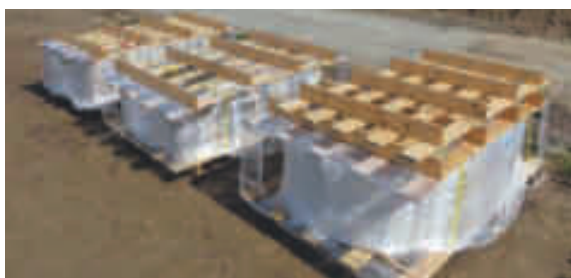
搬入事例：各パレット30セットの未使用型枠
