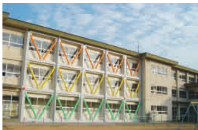
内灘町立鶴が丘小学校（石川県）
