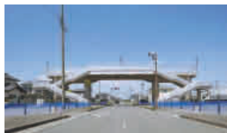
同上／A工区
