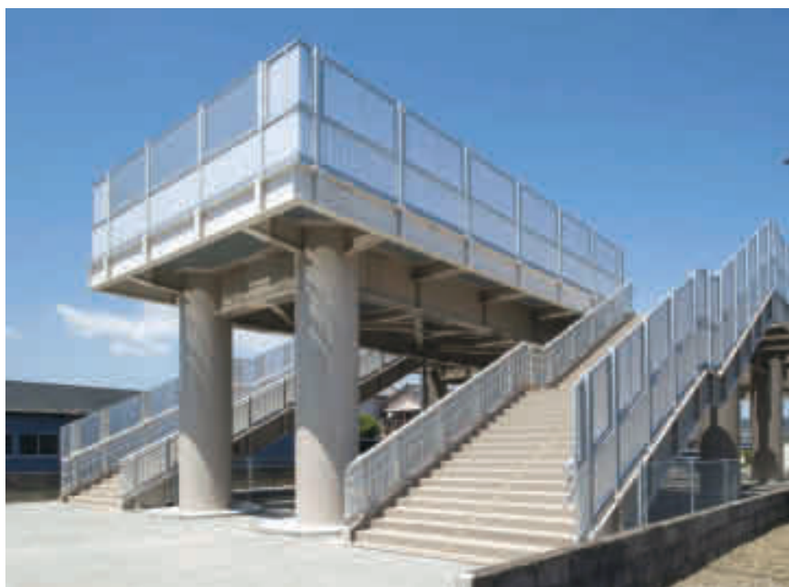
吉田町津波避難タワー（静岡県）／P工区
