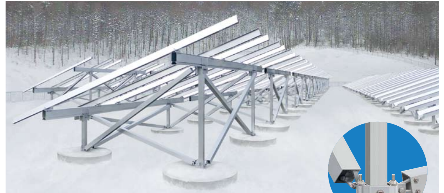
▲多雪仕様タイプ大型物件施工例
