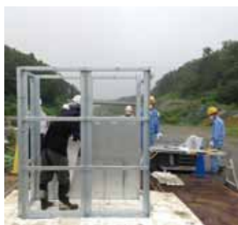
遮蔽ブースの設置
