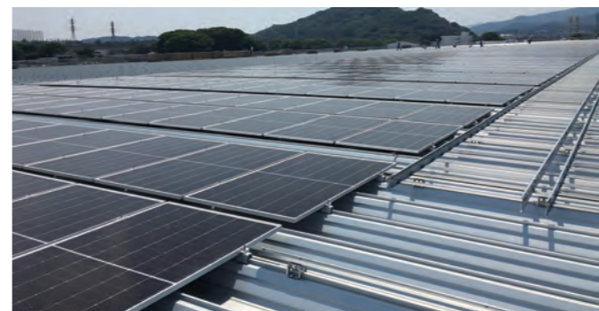
▲ 折板屋根用ソーラー固定金具
